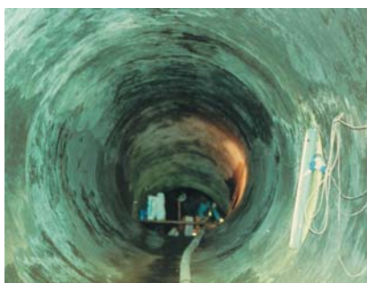
Veduta parziale di un tratto della condotta forzata interessata dagli interventi di ripristino strutturale (Fixbeton TX) e impermeabilizzazione (Vandex Super)
