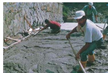
Posizionamento della rete elettrosaldata e stesura della malta strutturale Fixbeton TX
