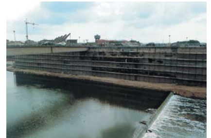
Veduta d'insieme della parete in cemento armato realizzata su una sponda del fiume Arno interessata dall'esteso intervento di ripristino e impermeabilizzazione (Fixbeton 45 e Vandex BB75)
