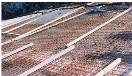
Posizionamento della rete elettrosaldata e stesura della malta strutturale Fixbeton TX
