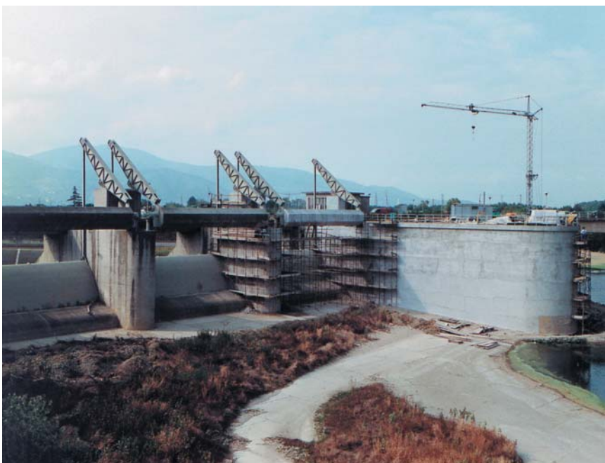
Veduta parziale della chiusa del canale scolmatore di Pontedera oggetto degli interventi di ripristino e impermeabilizzazione
