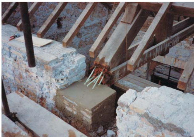
Inserimento nella trave sana delle barre in VTR.
