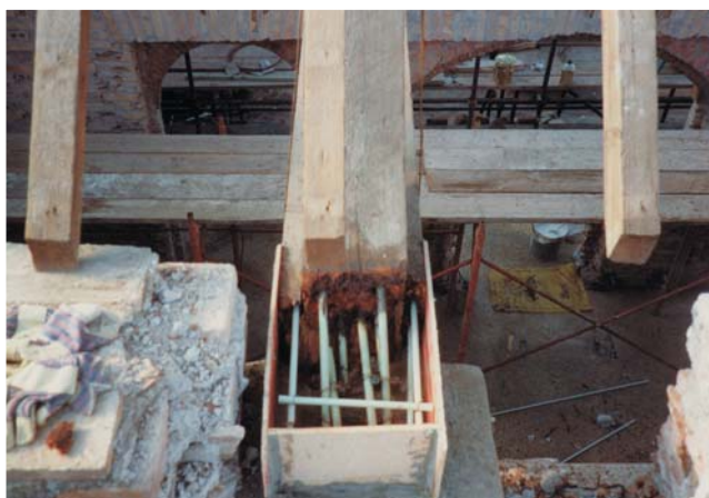
Predisposizione della cassetteria a perfetta tenuta.
