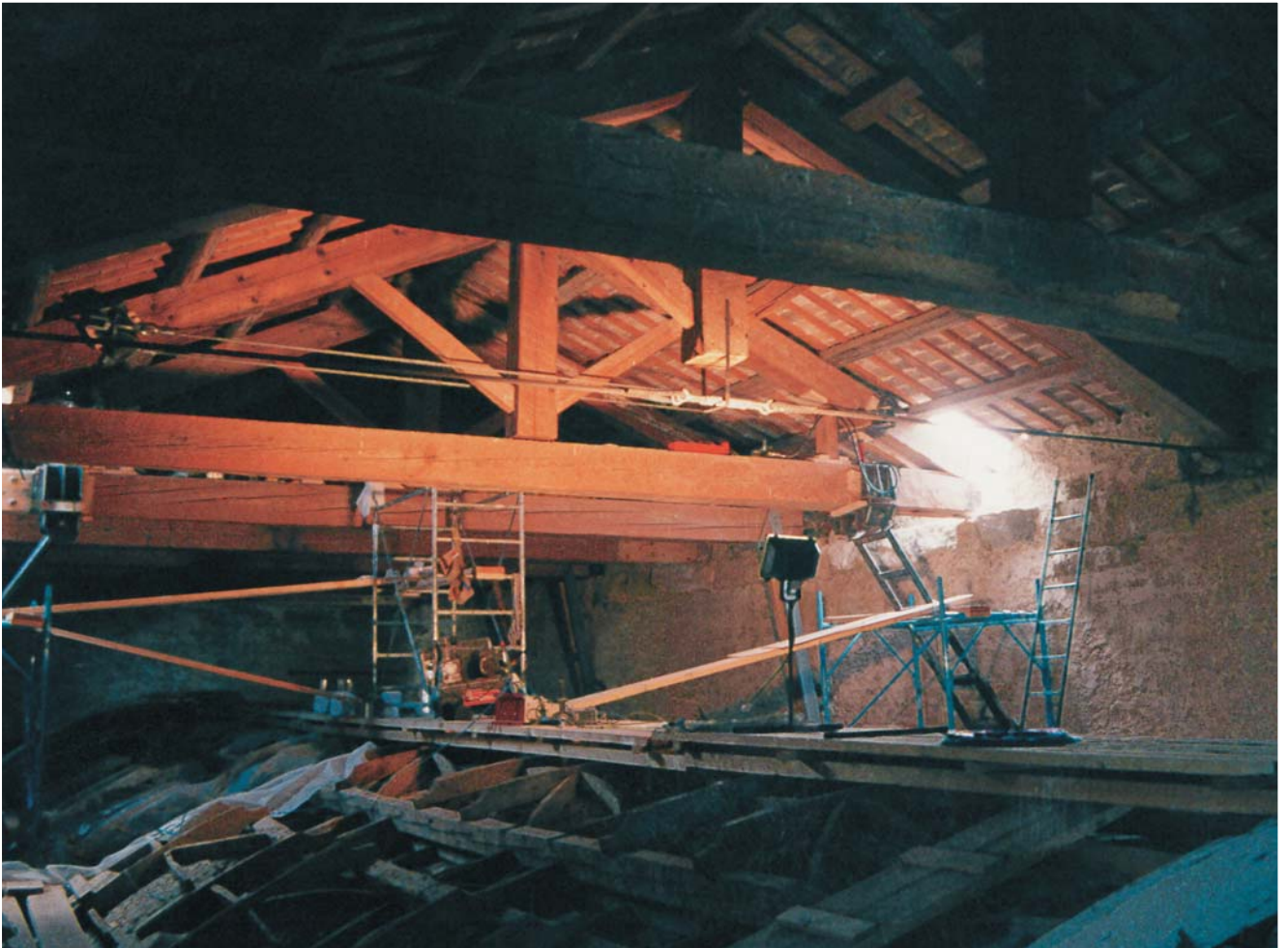
Ripristino del nodo "puntone-catena" di una capriata, mediante protesi lignea solidarizzata con EPOFIX W.
