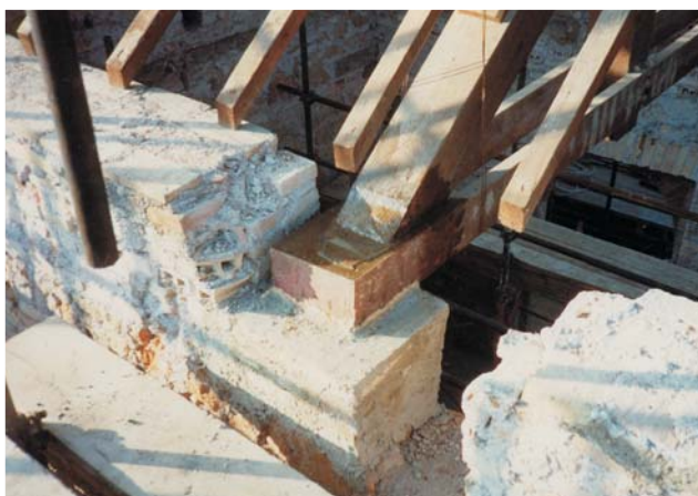
Ultimazione del getto con EPOFIX W caricato con inerti quarziferi. La colorazione della resina "marrone fratino" è stata studiata per uniformarsi al colore originario della struttura lignea.
