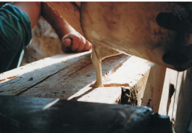
Ripristino del nodo "puntone-catena" di una capriata, mediante protesi lignea solidarizzata con EPOFIX W.
