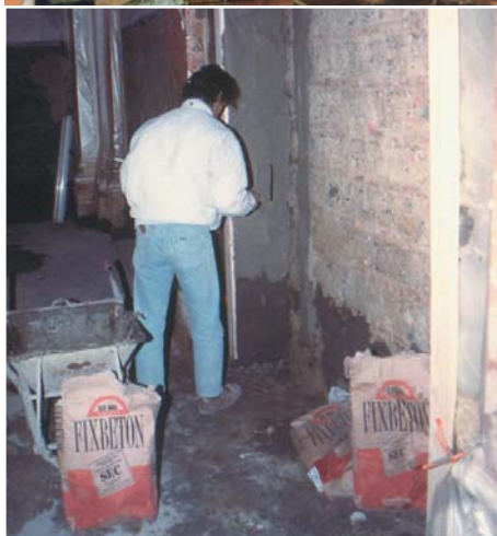
Fase applicativa dell'intonaco macro poroso FIXBETON SEC .
