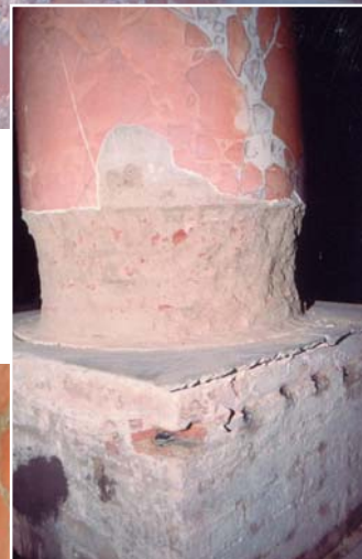
Particolari esecutivi dell'intervento. Tutte le colonne della chiesa, interessate dall'umidità di risalita, sono state oggetto dell'intervento VANDEX VIM (VANDEX INJECTION MORTAR)
