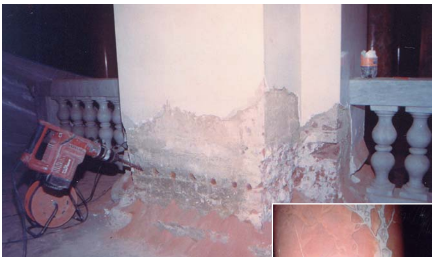
Particolari esecutivi dell'intervento. Tutte le colonne della chiesa, interessate dall'umidità di risalita, sono state oggetto dell'intervento VANDEX VIM (VANDEX INJECTION MORTAR)
