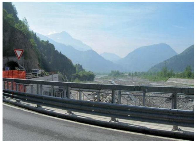
L'area di intervento
