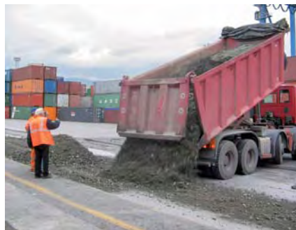
Ricoprimento del geocomposito
