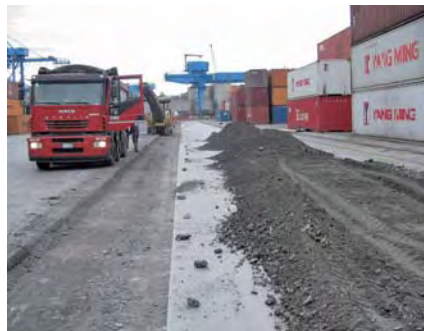
Scarifica della pavimentazione esistente
