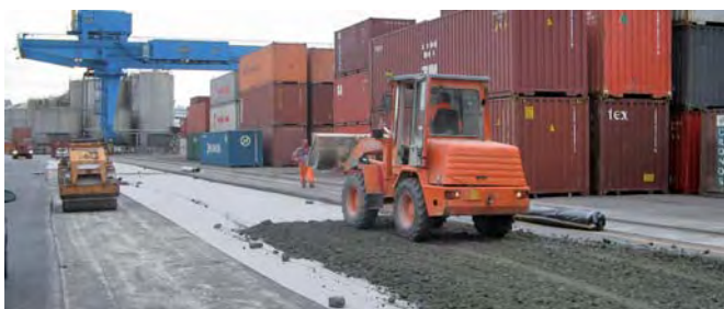
Compattazione della fondazione
