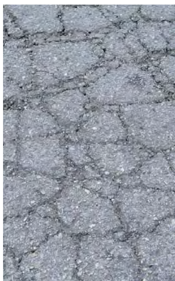
Lo stato prima dell'intervento
