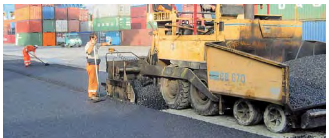
Realizzazione manto bituminoso
