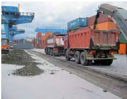
Scarifica della pavimentazione esistente
