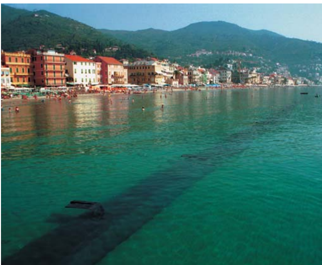
Berma soffolta a protezione del litorale del Comune di Alassio
