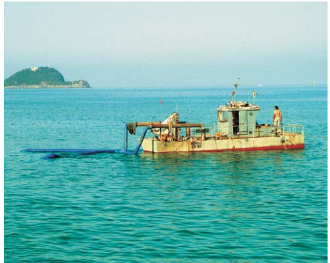
Operazione di riempimento con sorbona
