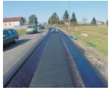
Posa in opera del geocomposito Armopal
