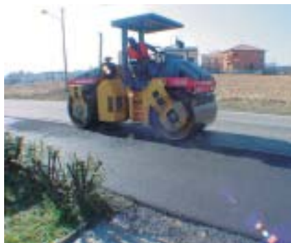
Operazione di compattazione
