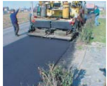
Stesa del conglomerato bituminoso
