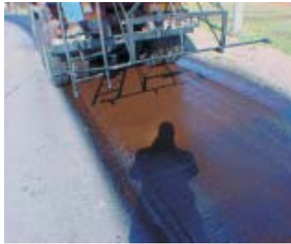
Diffusione dell'emulsione bituminosa
