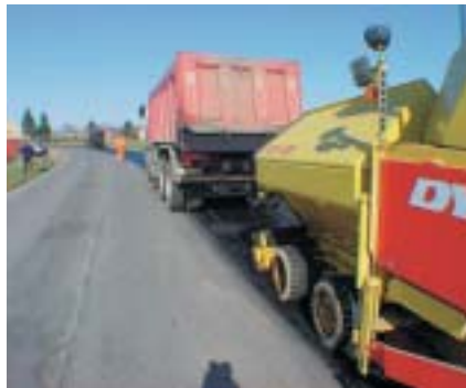
Operazione di rifornimento della finitrice
