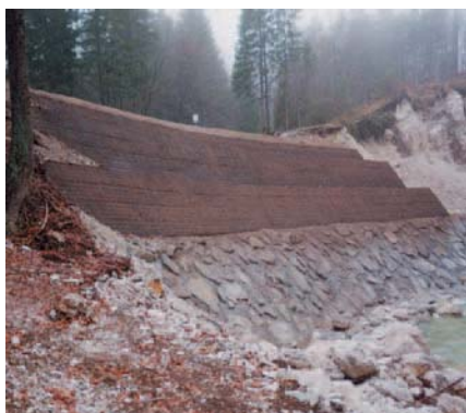
Il fronte realizzato
