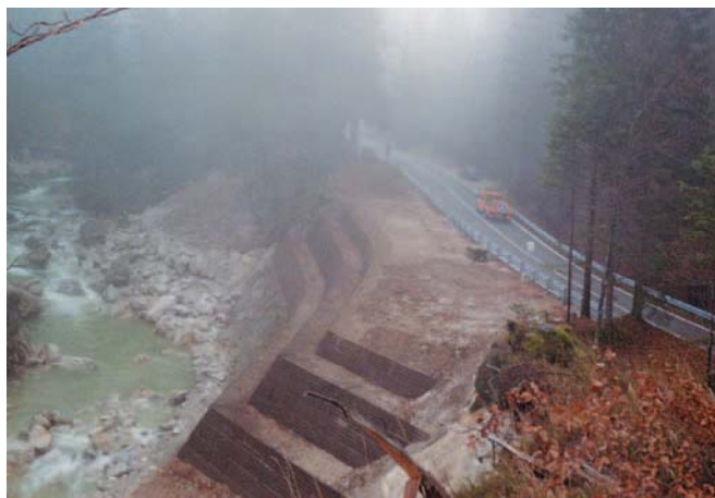
Il fronte subito dopo la realizzazione
